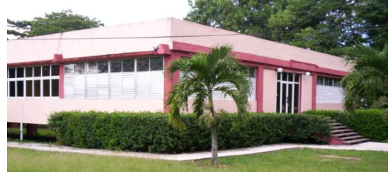
Figura.7: Edificación construida en la década del 80
